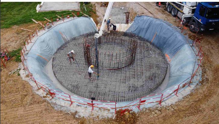
La couronne de béton de 12m de diamètre armée de 16 pieux
